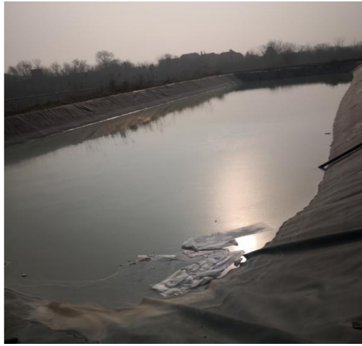
初期雨水收集池
