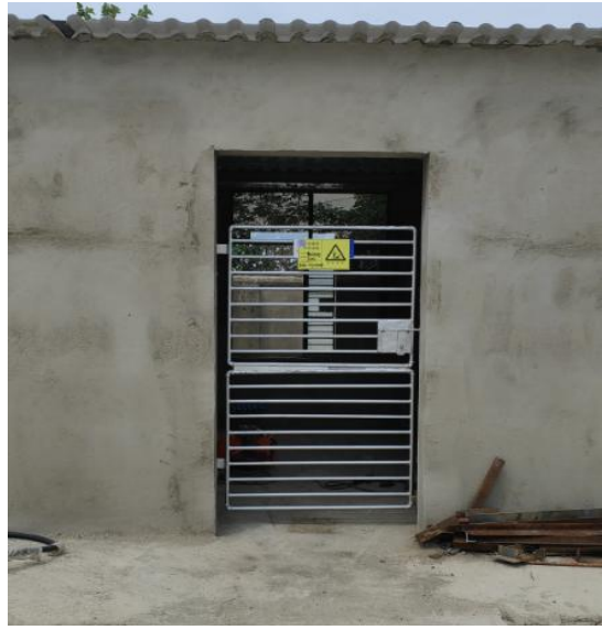
危险废物暂存间
