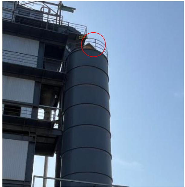
矿粉筒仓顶除尘器
