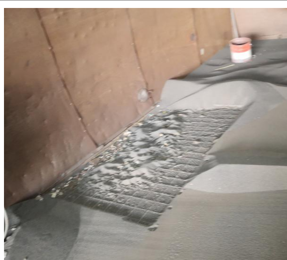
喷砂废气收集管道
