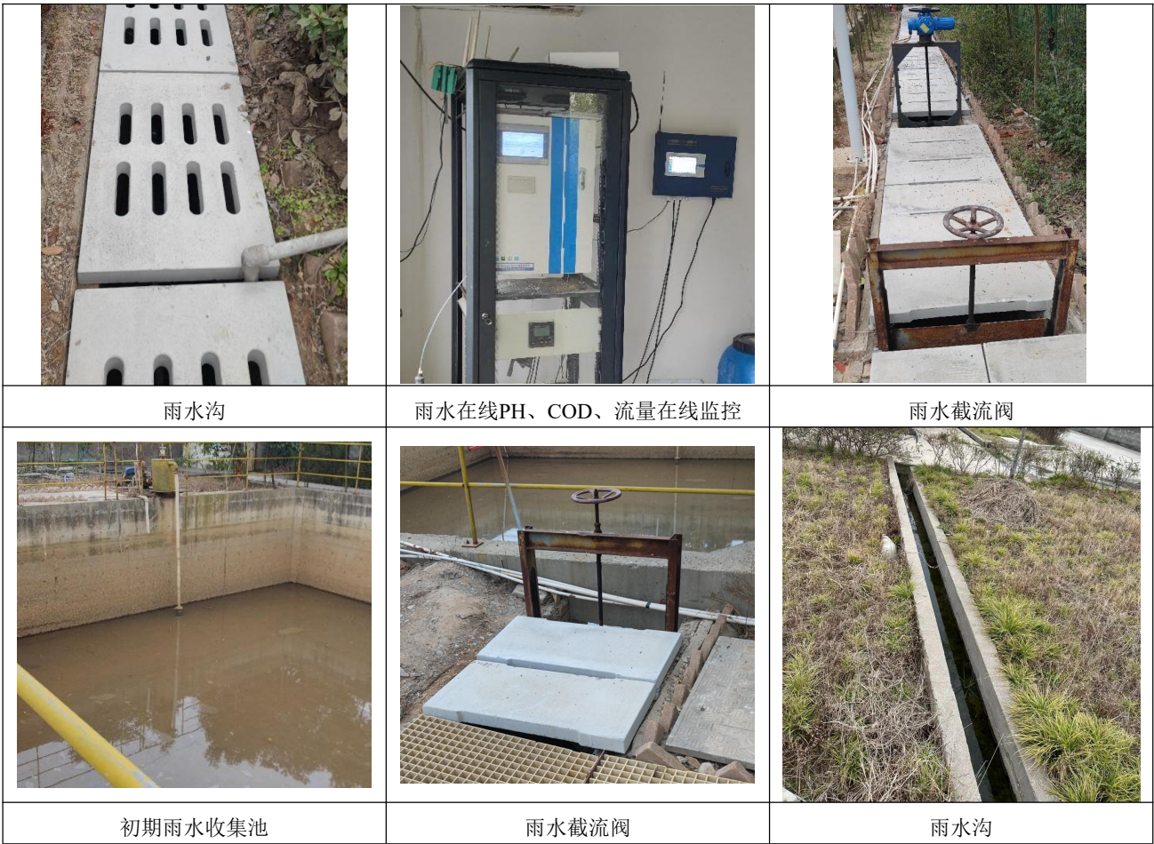
图 4.1-3 厂区初期雨水收集系统图
