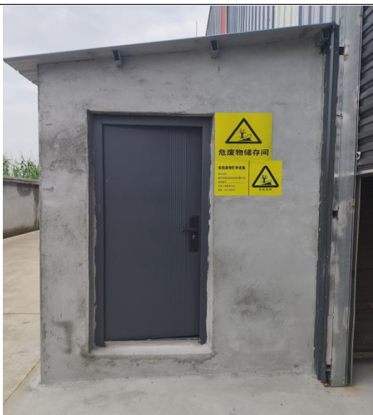
危废暂存间及标示牌
