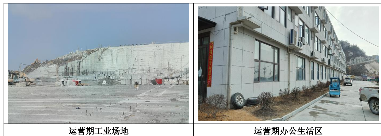
图4-2 项目现场情况图
