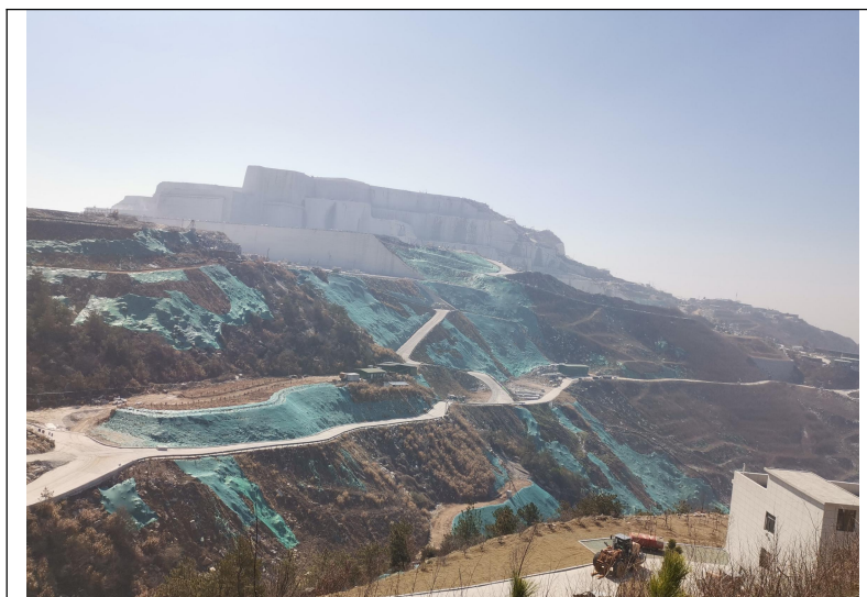
图4-10 项目矿区边坡复绿图
