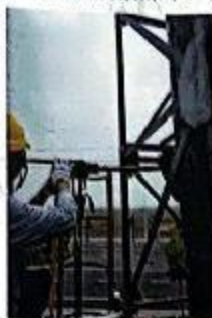
污水处理站废气排气筒出口
