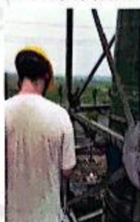
污水处理站废气排气筒
