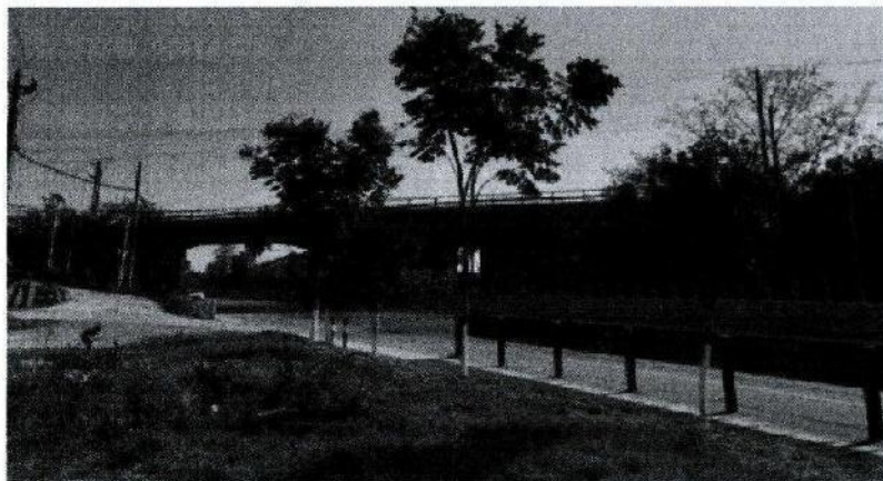
图 6-6 G220/京九铁路交叉跨越段现场照片
