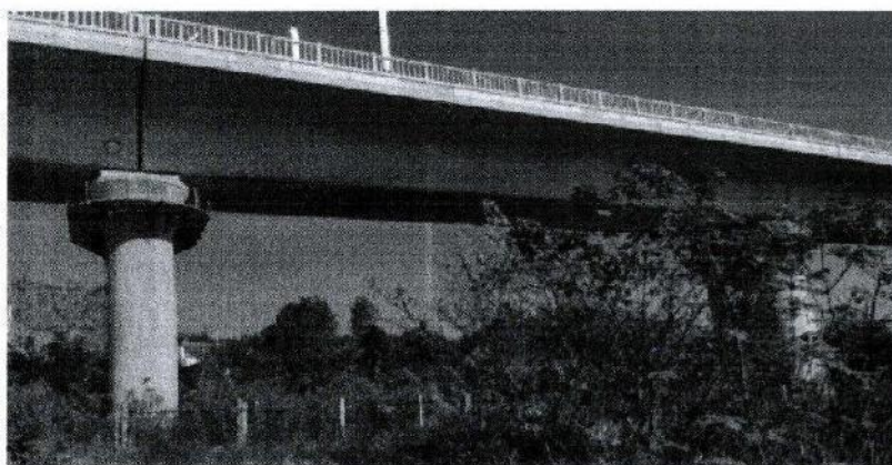
图 6-7 黄黄高铁穿越段现场照片
