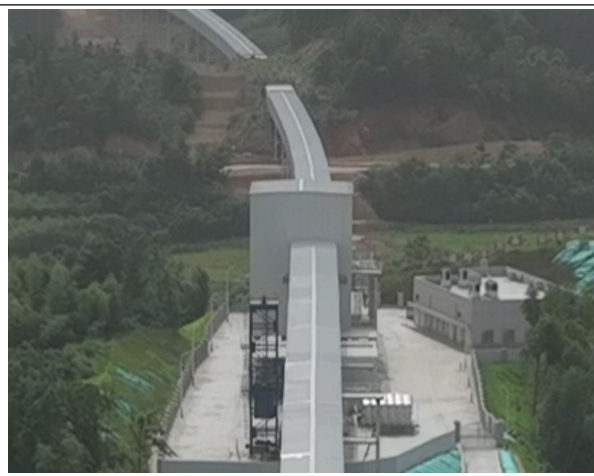
封闭的转运站
