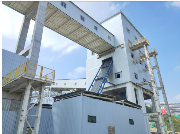
封闭的转运站
