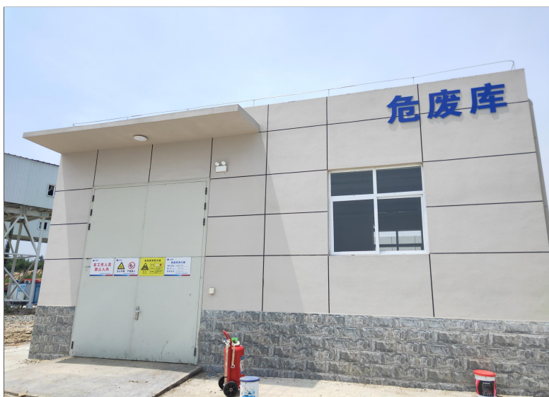
图4-10 危废暂存间图（依托矿山砂石加工厂）
