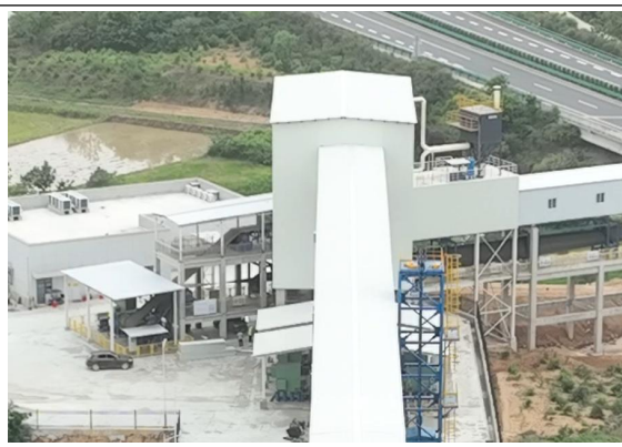
封闭的转运站
