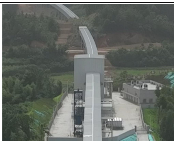
封闭的转运站
