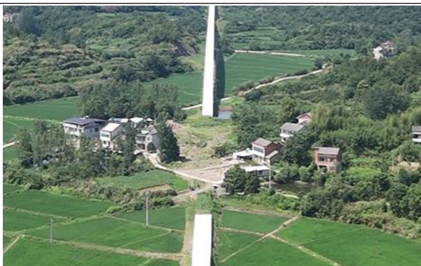
穿越居民的埋地廊道
