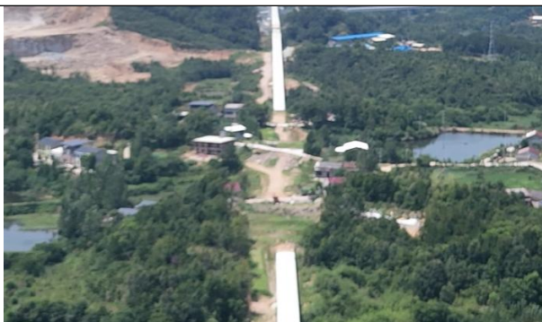
穿越居民的埋地廊道
