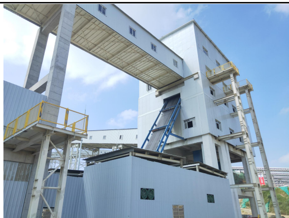
封闭的转运站
