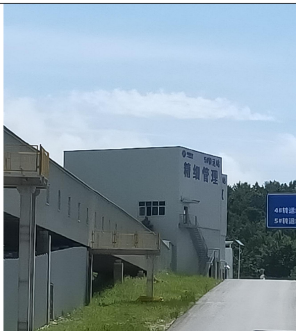
封闭的转运站
