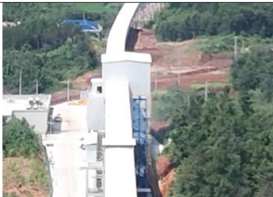
封闭的转运站
