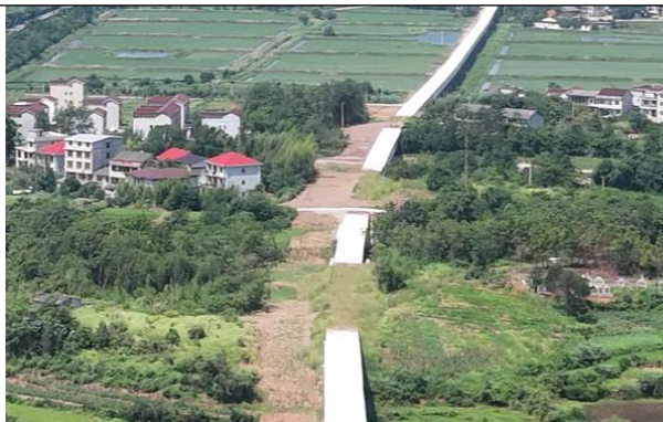
穿越居民的埋地廊道
