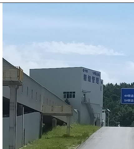
封闭的转运站
