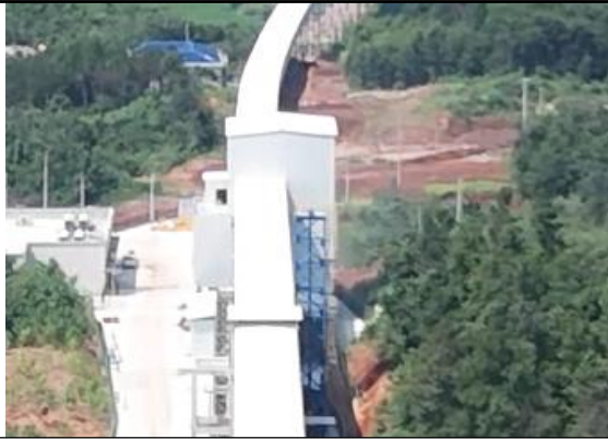
封闭的转运站
