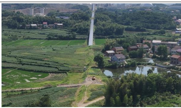
穿越居民的埋地廊道
