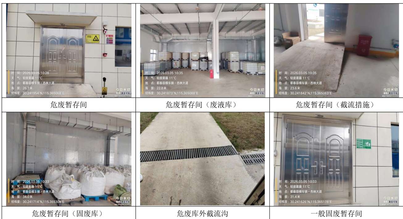
图 4.1-7 项目危废暂存间建设情况图
