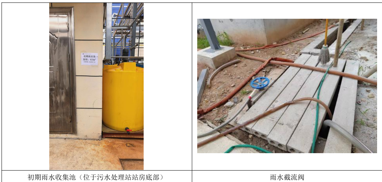
图 4.1-4 项目初期雨水收集系统图
