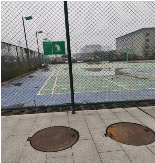
生活污水排放口
