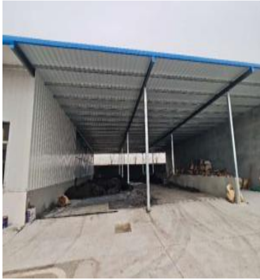
一般固废暂存间
