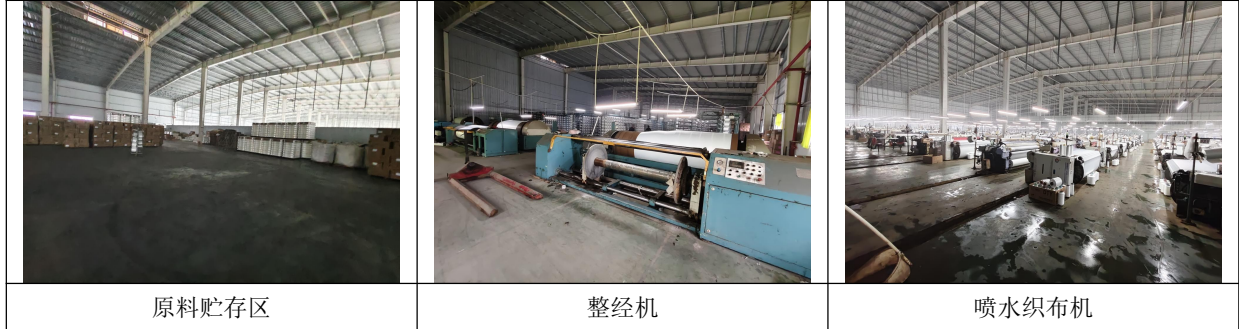
图 2-1 项目现场情况图片
