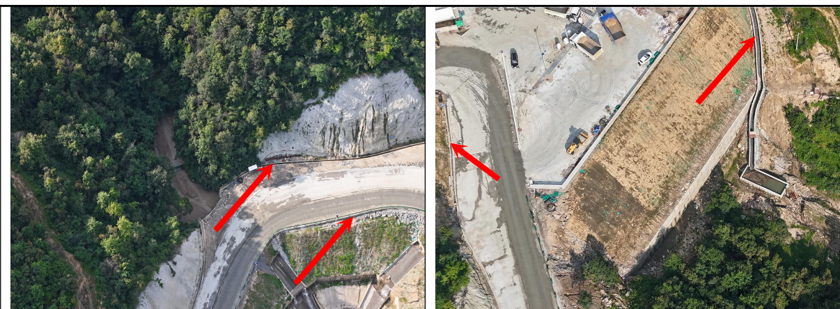
图4-9 项目矿区截排水沟图
