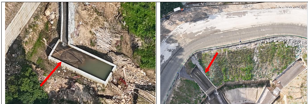
图4-10 项目矿区沉砂池图
