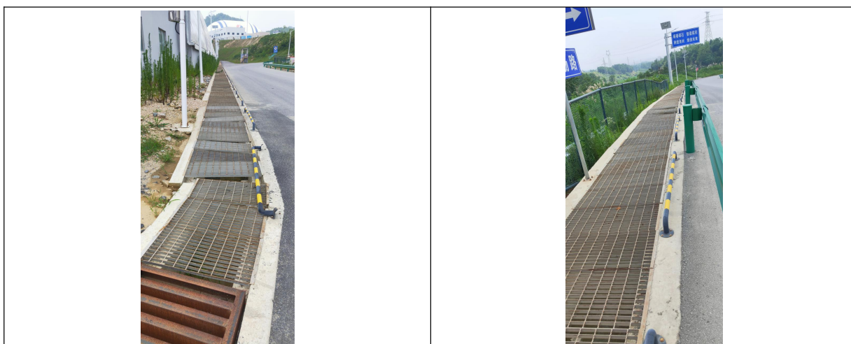
图4-12 项目加工系统区截排水沟图
