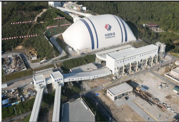
料仓转运皮带全封闭
