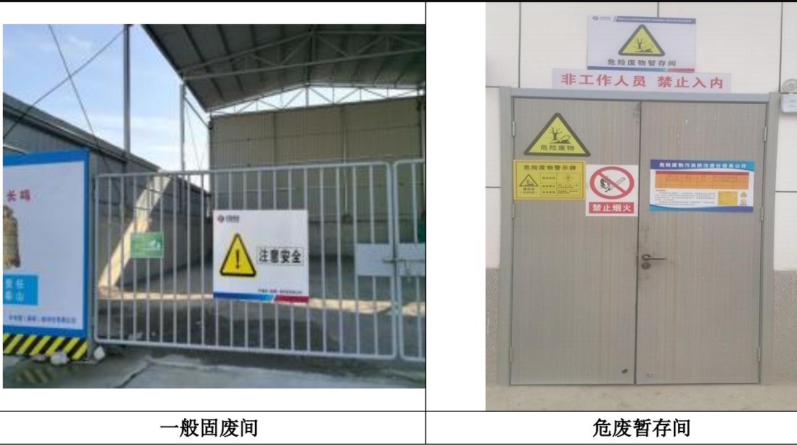
图4-21 项目运营期固废处置措施图
