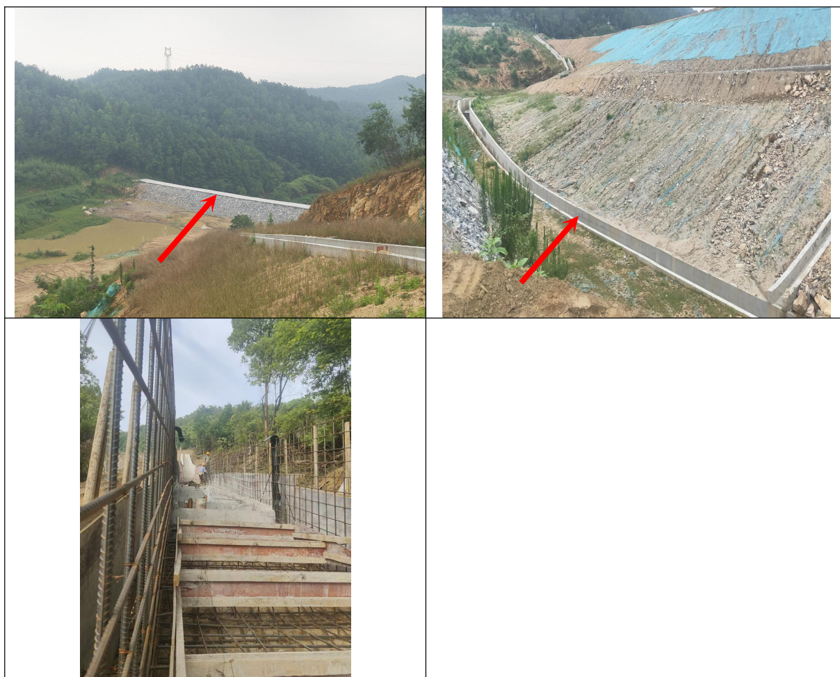
图4-16 项目排土场挡土墙和截排水沟图
