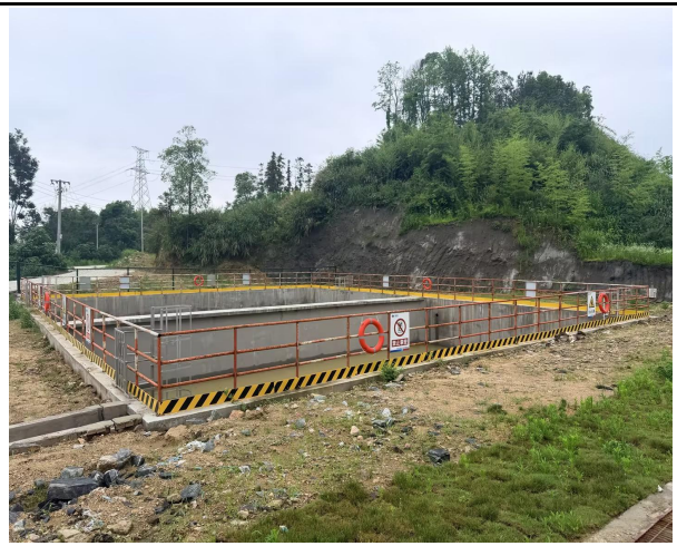
工业场地初期雨水池
