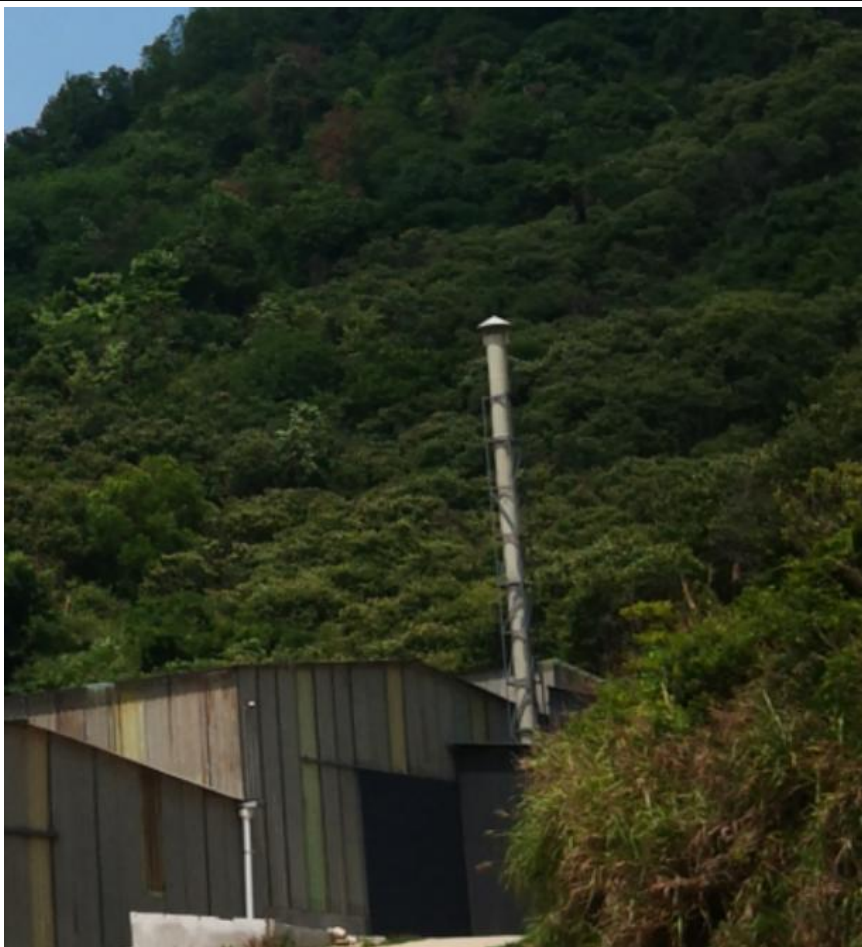
除臭废气排气筒
