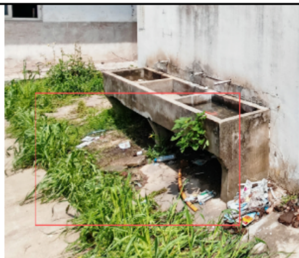
地理化粪池现状
