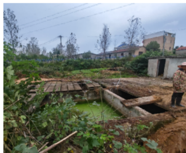
南侧初期雨水池
