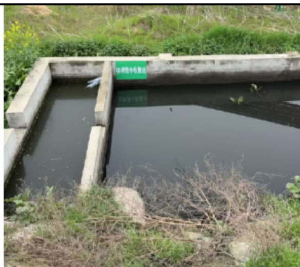
北侧初期雨水池
