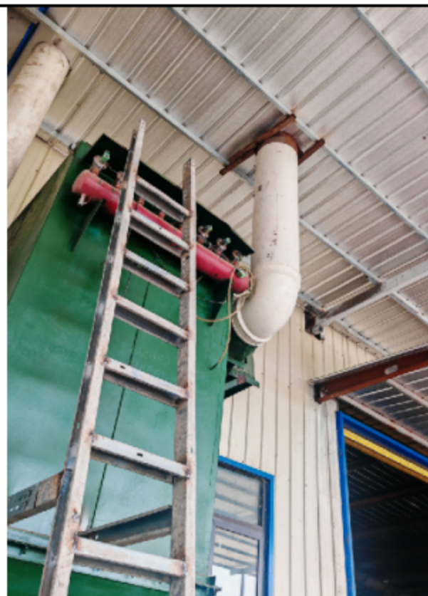
DA002 规范化设置情况（采样平台、采样孔及标识牌）
