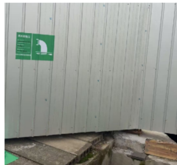
雨水排放口标识牌
