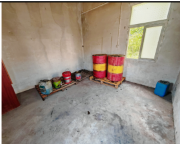
危废间内部防渗及托盘
