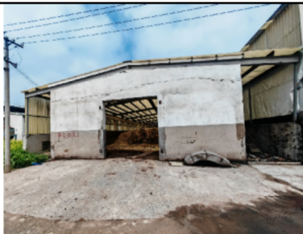
封闭辅料贮存间
