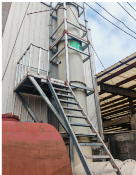
DA001 规范化设置情况（采样平台、采样孔及标识牌）
