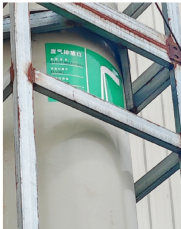
DA001 规范化设置情况（采样平台、采样孔及标识牌）
