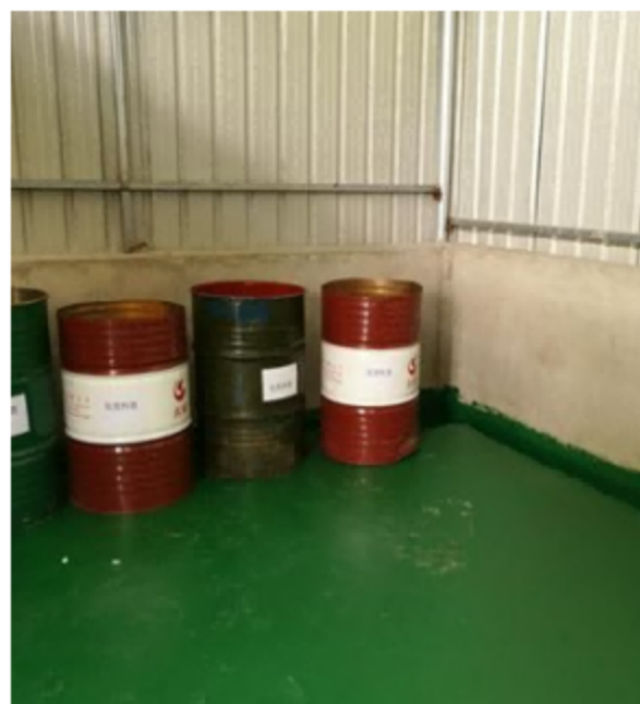
危废间内部防渗及托盘
