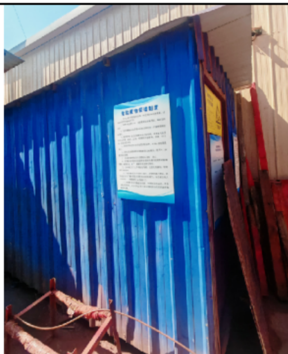
危废暂存间整体照片
