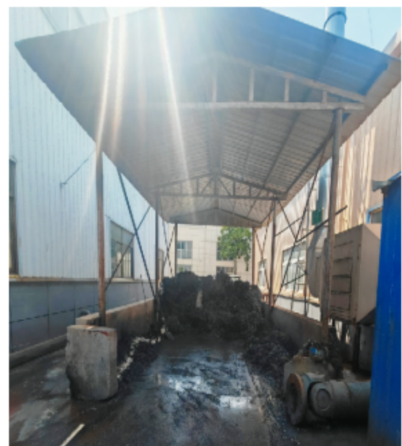
一般固废存储区及标识牌
