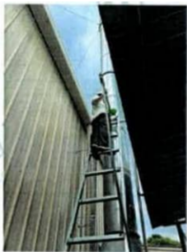
刷漆房废气排放口
